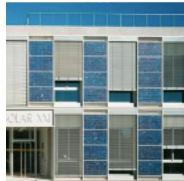
図1：BIPVの建築側面設置<sup>i</sup>
