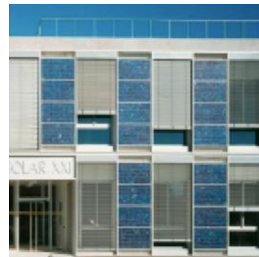
図1：BIPVの建築側面設置 i
