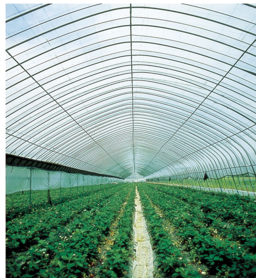
マルイチのパイプが使われてグリーンハウス
