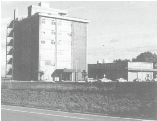
図2 実験研究棟竣工当時の溶接研
