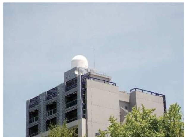
図1 大阪大学吹田キャンパス電気系建屋屋上に設置されているフェーズドアレイレーダの写真
