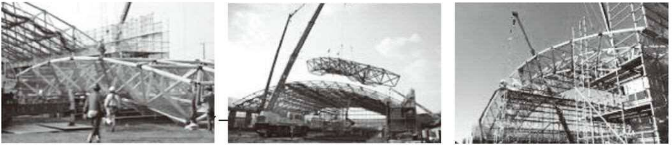
地組みブロック
