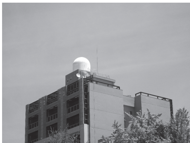
図1 大阪大学吹田キャンパス電気系建屋屋上に完成したフェーズドアレイレーダ
