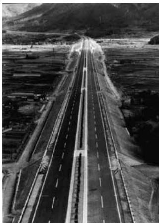
写真1 開通当初の名神高速道路(京都山科付近: 写真の奥左方が京都東インターチェンジ)
