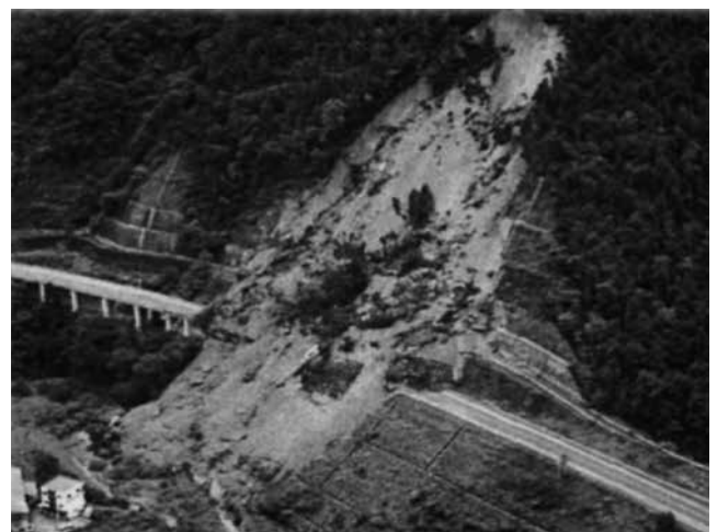
写真6 高速道路用地外からの地山の崩壊状況
