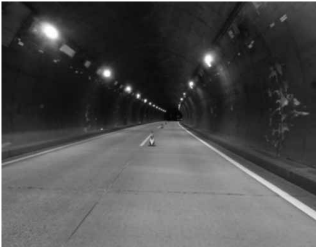
写真7 トンネル内での視環境の改善
