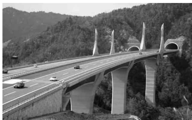
写真3 供用された新名神高速道路(近江大鳥橋: 平成18年度の土木学会「田中賞」を受賞)
