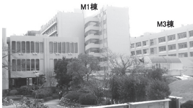
図 1 改修後の M1 棟 (右手は新 M3 棟)
