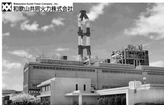
図 1 和歌山共同発電所
