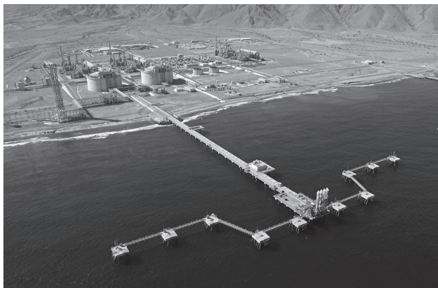
オマーン LNG 液化設備 [写真提供：カルハット LNG]
