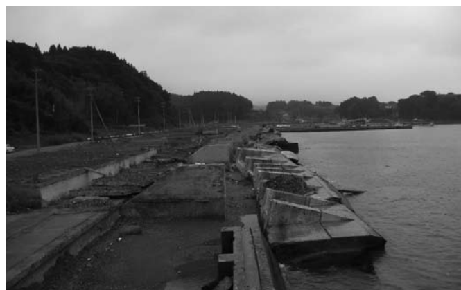
写真-3 津波で倒壊した海岸堤防
