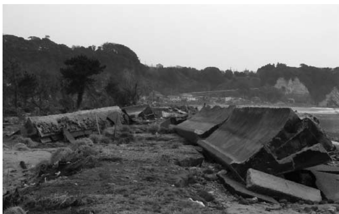
写真-3 津波で倒壊した海岸堤防
