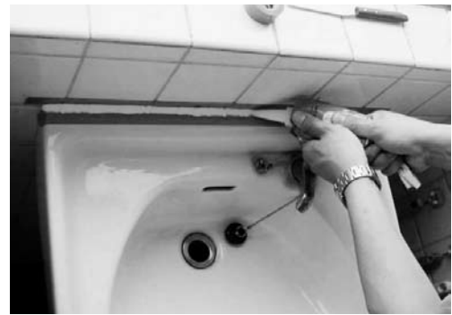
バスシール 洗面台への施工
